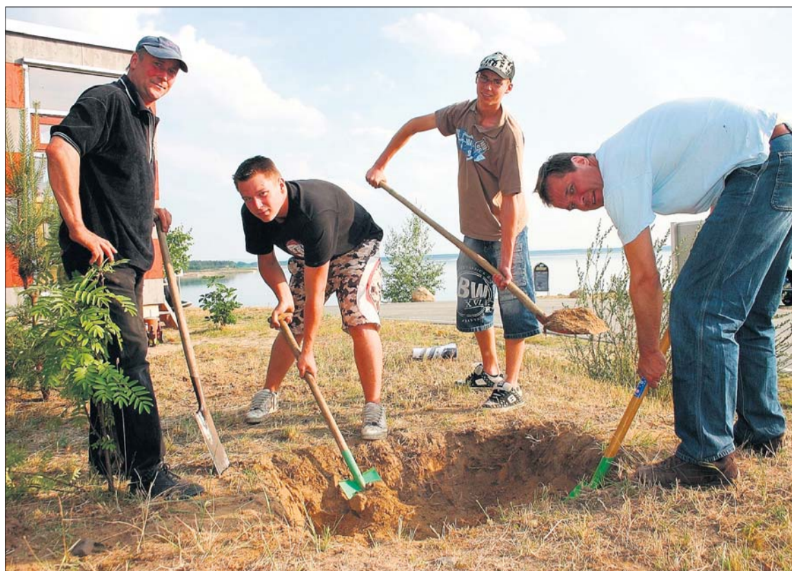
Schwitzen für die Kunst: Sechs ein Meter tiefe Löcher für die Fundamente der Wortsäulen haben Heinz Bittner, Steven Burghardt und Martin Krupper gemeinsam mit dem Hamburger Künstler Rupprecht Matthies (v.l.) ausgehoben.
